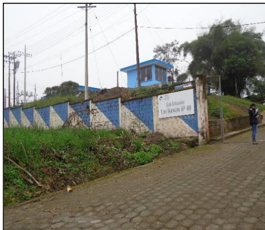
Fotografía No. 12 Subestación No 49 Los Bancos
