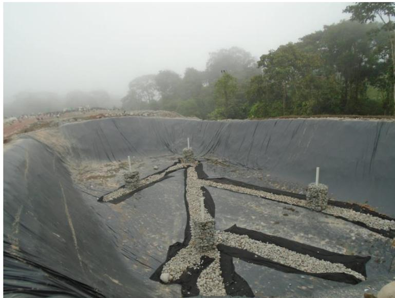
**Fotografía 11.** Geomembrana ubicada como parte de la ejecución del proyecto cierre técnico del Botadero, 2014.
